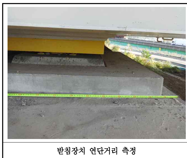
【사진 41.3.13】 교량받침장치 연단거리측정
