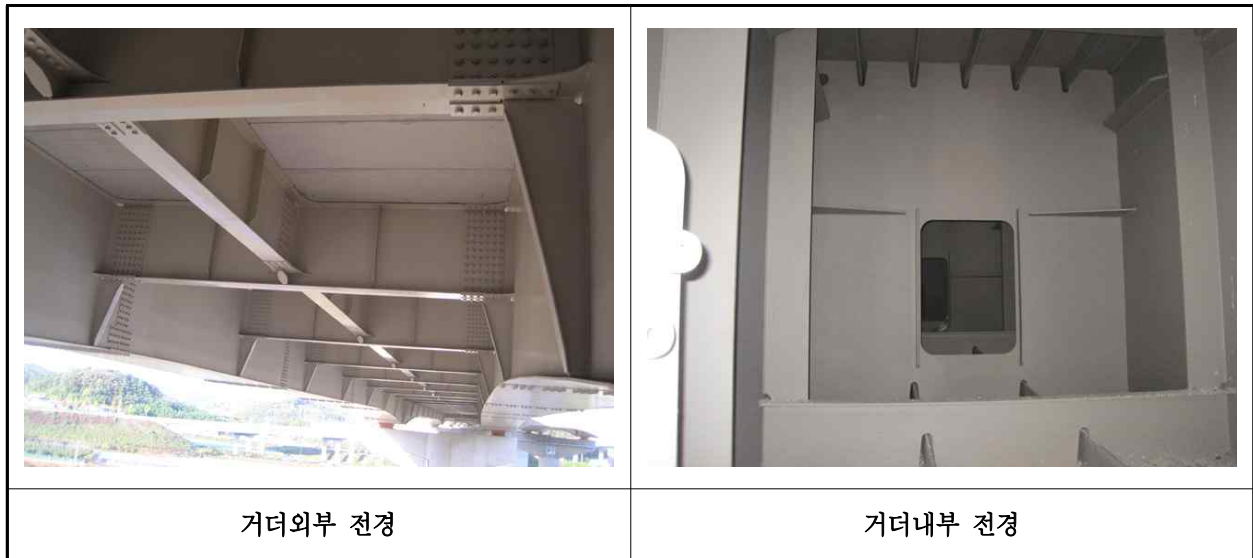
【사진 41.3.4】 거더 전경
