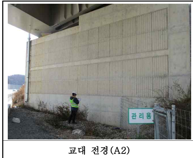
【사진 41.3.7】 교대 전경
