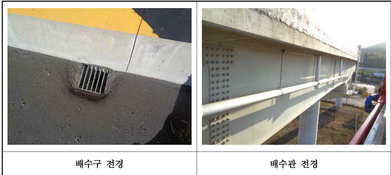
【사진 41.3.20】 배수시설 전경
