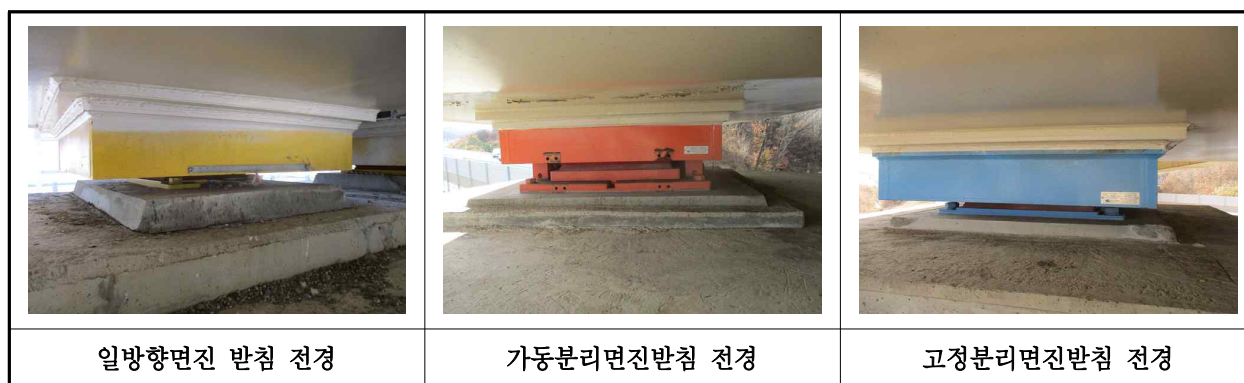
【사진 41.3.11】 교량받침 전경
