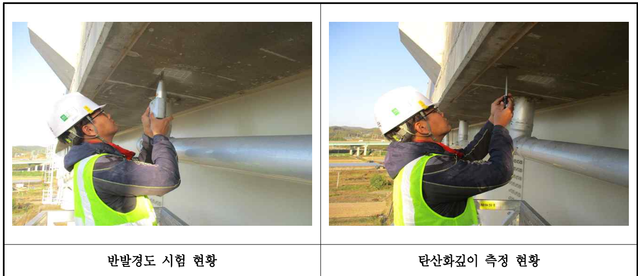
【사진 1.4.1】 콘크리트 내구성조사 현황
